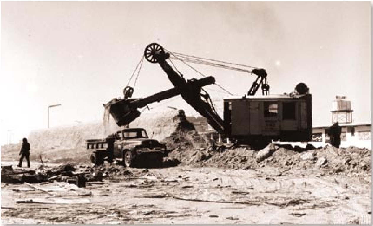
عملية حفر الموقع الخاص بشركة نفط الكويت
